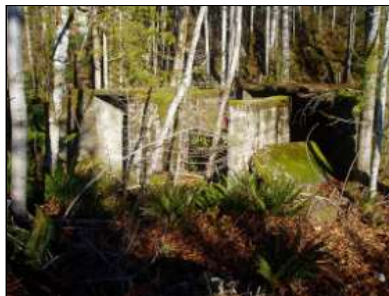
No. 5 Mine Fan House (G. Sproule)
